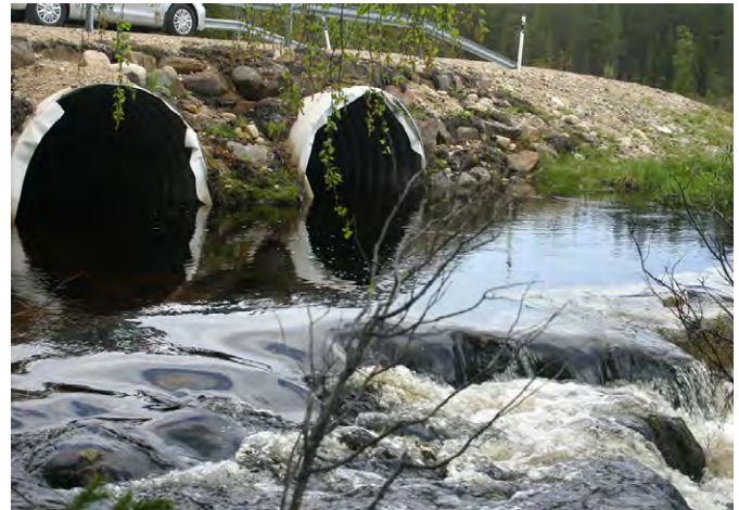
Kuva 84. Tierumpujen asennussyvytyden tulee mahdollistaa kaloille esteetön kulku myös alivirtaamakaudella. LAURI KARVONEN.
