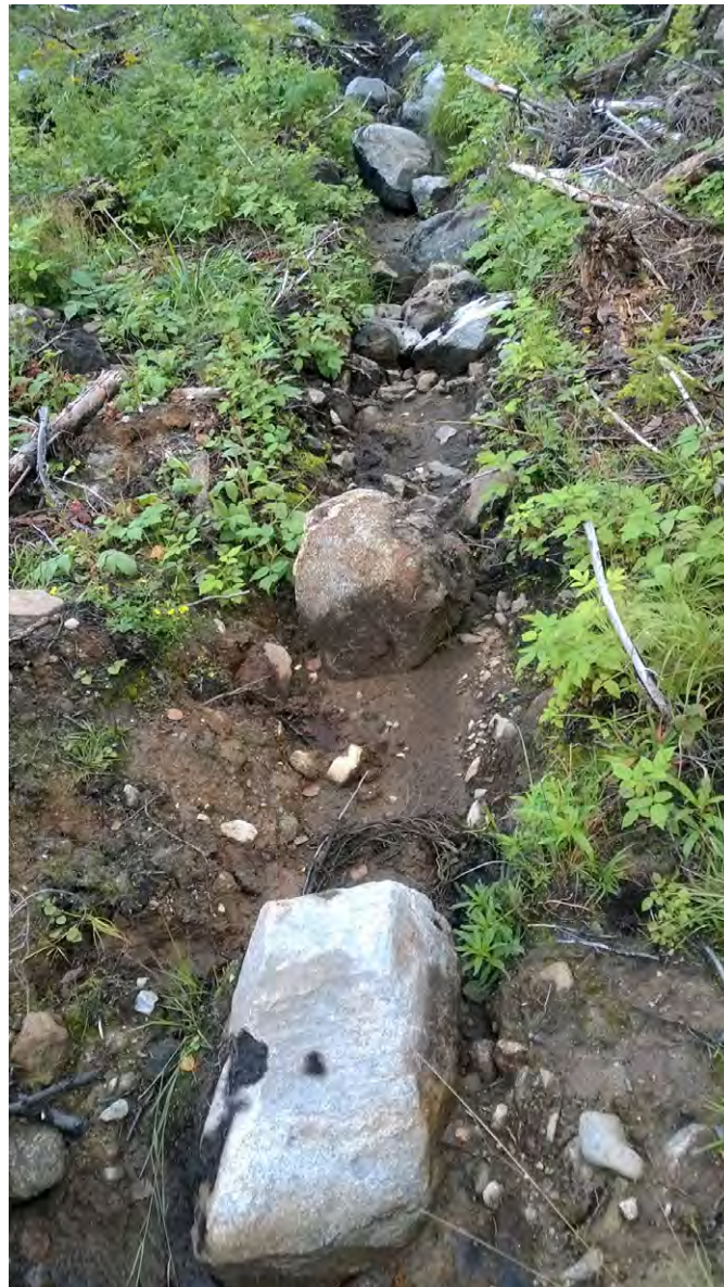
Kuva 74. Etenkin kaltevilla paikoilla voidaan hidastaa veden virtausta ja estää syöpymistä katkomalla naveroa kivillä. ARI RAUTIO.
