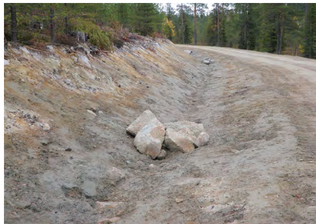
Kuva 85. Kivistä tehdyillä ojakatkoilla voidaan hidastaa veden virtausta ja vähentää ojien syöpymistä. MARKKU TERVONEN.
