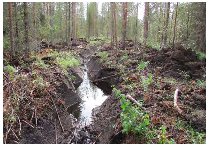
Kuva 76. Lietekuopat pidättävät veden mukana kulkeutuvaa kiintoainetta. MARKKU TERVONEN.
