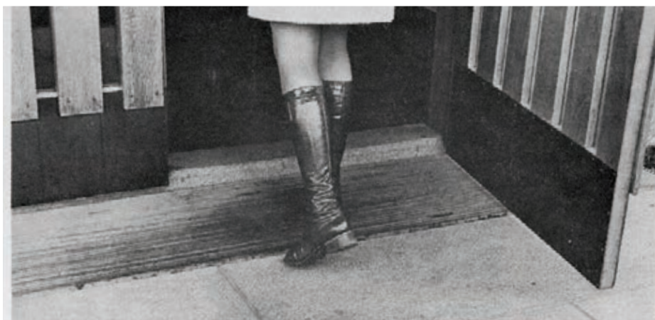
Useimmissa suomalaisissa rakennuksissa on ritilät liian kapeat. Näin on myös Otaniemessä. Sisäpuolelta sijaitseva esteismatto ei ole sitä leveämpi. Nyt astuu sisääntulija ensimmäisen askelensa ritilälle, toisen esteismattoille ja kural irtoavat jalkineista vasta sisätiloissa. Jotta ritillä ja matto täyttävissä tehtävänsä pitäisi niiden olla ainakin kaksi kertaa näin leveitä.
