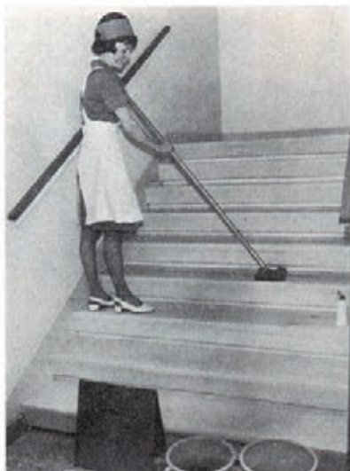
Liian vaaleiden lattiamateriaalien valinta peikastaan koristeisista on eräs arkkitehtiemme yleisimmistä virheistä. Nämä vaaleat portaat kuluttavat aivan tarpeettomat määrät siivousaikaa ja -aineita. Huolimatta huoltollisesta puhdistuksesta likaantuvat ne heti ensimmäisten käyttäjien esteisiksi niitä. Portaat puhdistetaan käsityönä joka päivä kaikkien 12 kerroksen matkalla. Portaisissa on lisäharmina kapea varvastila, joka vaikeuttaa koneiden käyttöä. Varvastilan seinämät ovat rosoiset ja portaat ovat täynnä rakeja — nämäkin seikat hidastavat puhdistustyötä. — Rouva Mailis Kuusela suorittamassa jokapäiväistä uraansa.
