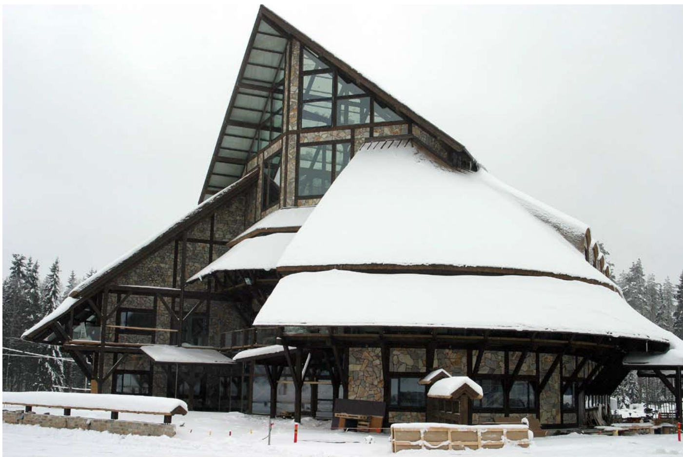
Biolanin uusi Eurassa sijaitseva pääkonttori ja sen käyttövesi lämpiävät kahdella Lämpöässä T 60 kW:n maalämpöpumpuilla.
