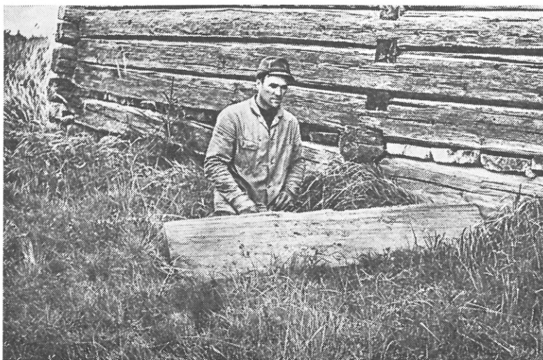
Pualin olla on vielä säilynyt ruumiin lauta, hongasta halkaisemalla tehty, jolle talossa kuolleet vainajat ennen vanhaan ojennettiin odottamaan arkkuun laittaa ja hautausta.
