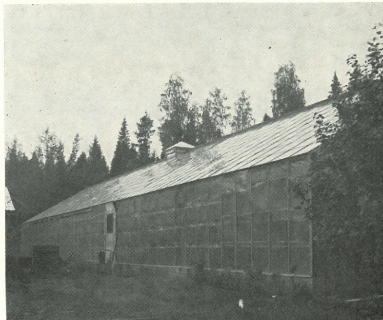
Kärkölän tilalla viime kesänä ensimmäistä kertaa käytössä ollut kasvihuone, joka on kooltaan 9x30 metriä. Rakennuskustannusten voimakkaan nousun johdosta tämänkokoiset kasvihuoneet tulevat maksamaan 60 000—70 000 markkaa.
