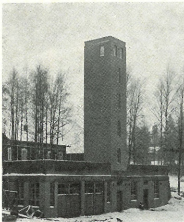
Vanha paloasema, joka sijaitsi nykyisen PYP:n paikalla. Takana kansakoulu, nykyinen kauppalantalo.
