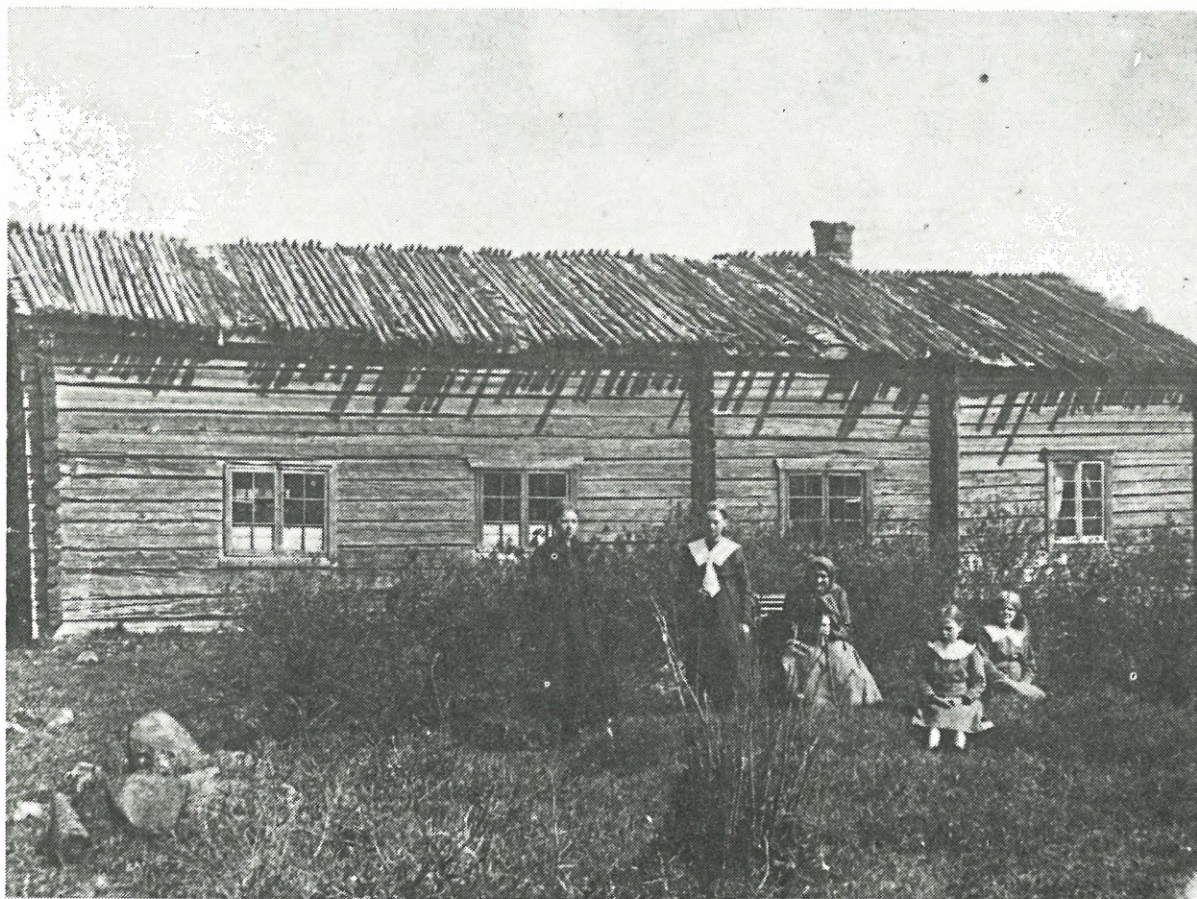
Kuivasjärven Kuivaston tilan vanha päärakennus valokuvattuna v. 1916. Se on rakennettu 1800-luvun alkupuolella ja purettu v. 1926. Rakennuksessa oli tuohimalkakatto ja sen vasemmassa päässä oli suuri 8 m x 9 m tupa. Henkilöt vasemmalta: Hilma Kuivasto, Elin Lehtonen, Severiina, Anni ja Aune Kuivasto.
