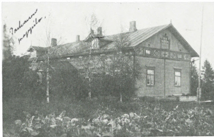
Yhkyisen asunsa Parkanon vanha pappila sai viimeistelytyöissä v. 1903. Huomaa koko rakennusta kiertävät koristukset seinän yläosassa. Myöhemmin kun rakennusta on ulkomaalattu on koristelut peitetty samalla maalilla kuin seinätkin eivätkä erotu ohikulkijan silmään sellaisina kuin tässä 1920 aikoihin otetussa kuvassa.
