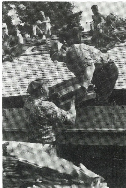
Vanhan katon korjausta.
