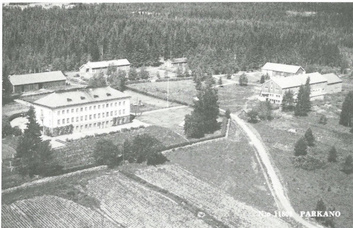
Asuinrakennus 3-kerroksisen Kunnalliskodin takana on maatilalla asuntola. Sivustalla maatilalla ulkorakennuksia.
