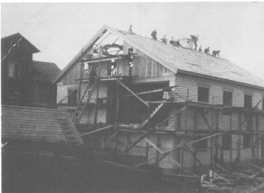
Uusi nahkuriverstas rakenteilla vuonna 1933. Se tehtiin tiilestä ja on vielä käyttökelpoinen. Taustalla rakennus, jossa raakanahat vastaanotettiin ja valmiita kuivatettiin. Nahka-puoti oli myös tässä rakennuksessa.
