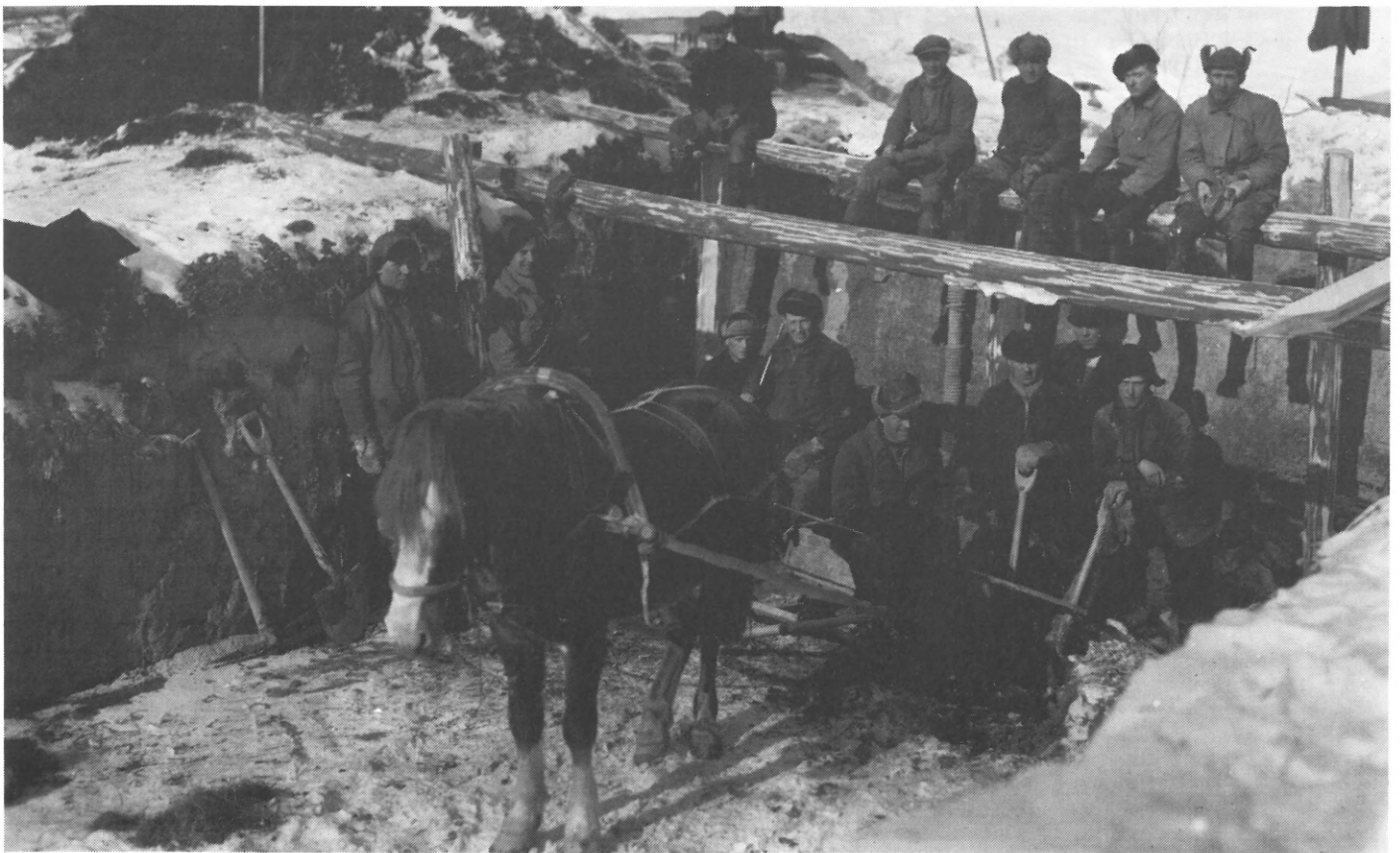
Korkomäen alikulkusillan perusmontun kaivu käynnissä ratatyömaalla 1933. Hevonen on Yrjö Uusivatusen ja ohjaksissa Paavo Niemi. Valokuva Anni Uusivatusen kokoelmista.
