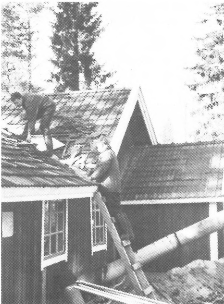
Heimo (vas.) ja Jarno Kivioja korjaamassa saharakennuksen kattoa.
