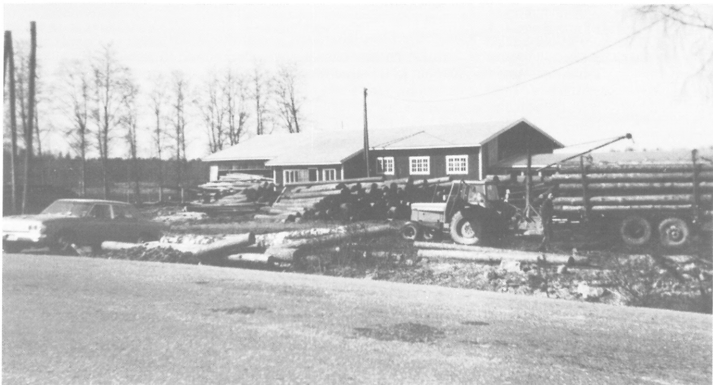
Tukkeja sahalle ajettiin sekä autoilla että traktoreilla. Tukkivarastolta puut siirrettiin sahan päähän traktorilla ja sahattu puutavara erikseen rakennettua rataa pitkin lautatarhaan. Kuvamme sahan alkuvaiheen tukkivarastolta.
