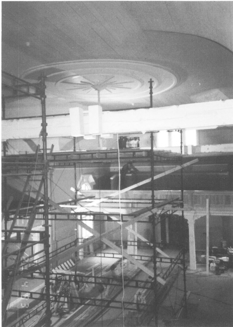
Rakennustelineet keskellä kirkkoa. Puusta tehty aurinko keskellä kattoa. Lehterien etuseinät kaavittu puhtaiksi vanhasta maalista. Kirvesmies laittamassa uutta seinämää lehterille levennetyn porraskäytävän yläpuolelle. Kuvan otti huh- tikuussa Tapio Kivelä.
