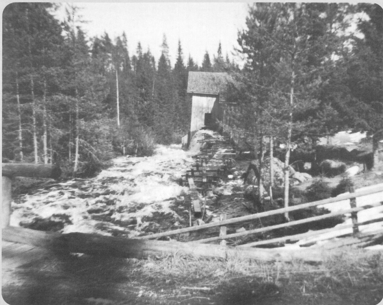
Kärppäluomaa ja siihen rakennettu vesiruuhi, jossa virtaava vesi pyöritti pärethöylää ja myllyä.
