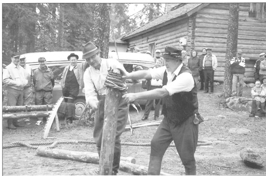
Uittotöissä ponttoon puomit sidotaan yhteen närevitjaksilla, joita kuvassa tukkilaiset kieputtavat.
