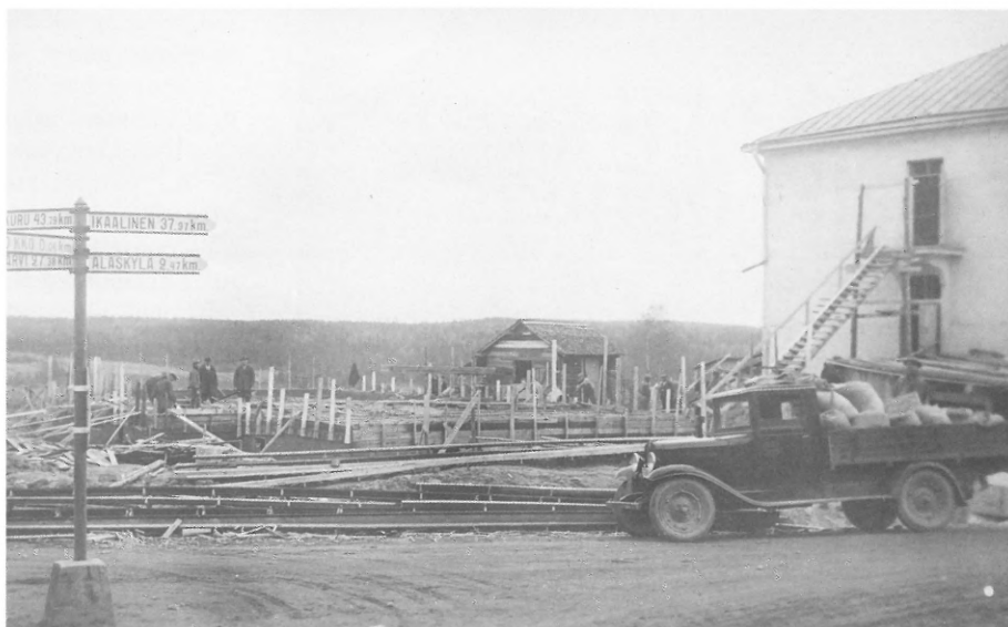
Kuin syksyllä 2001? Uutta osaa rakennetaan vuonna 1934.
