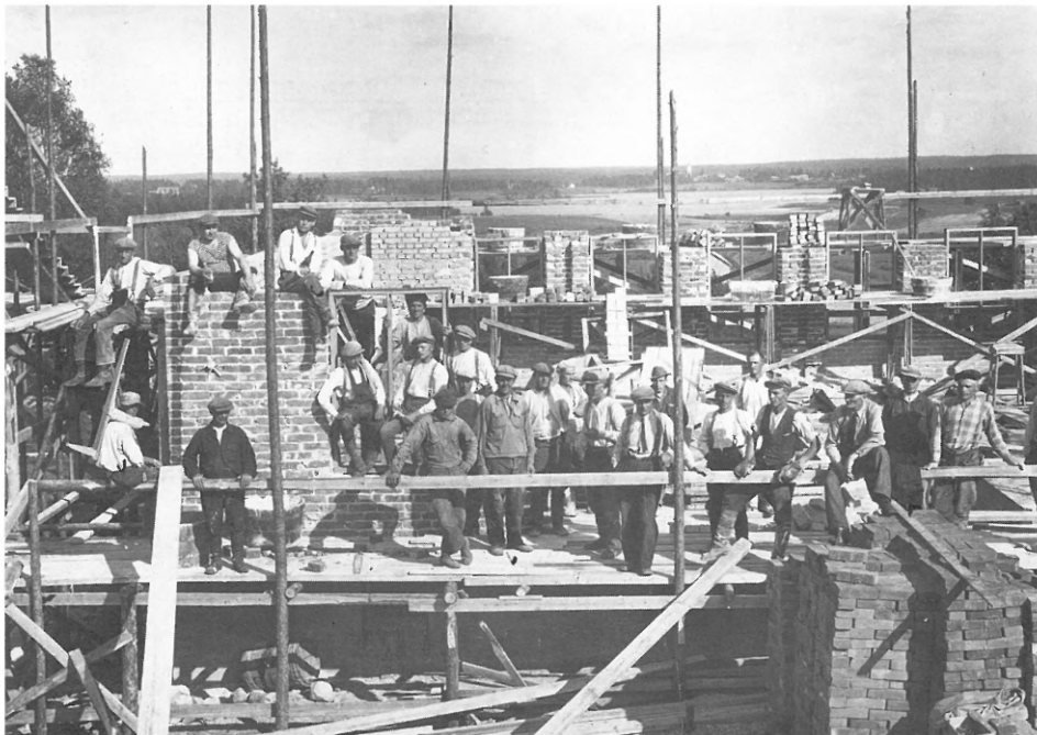
Parkanon kunnalliskoti rakenteilla 1930-luvulla. Taustalla Kirkkojärvi.
