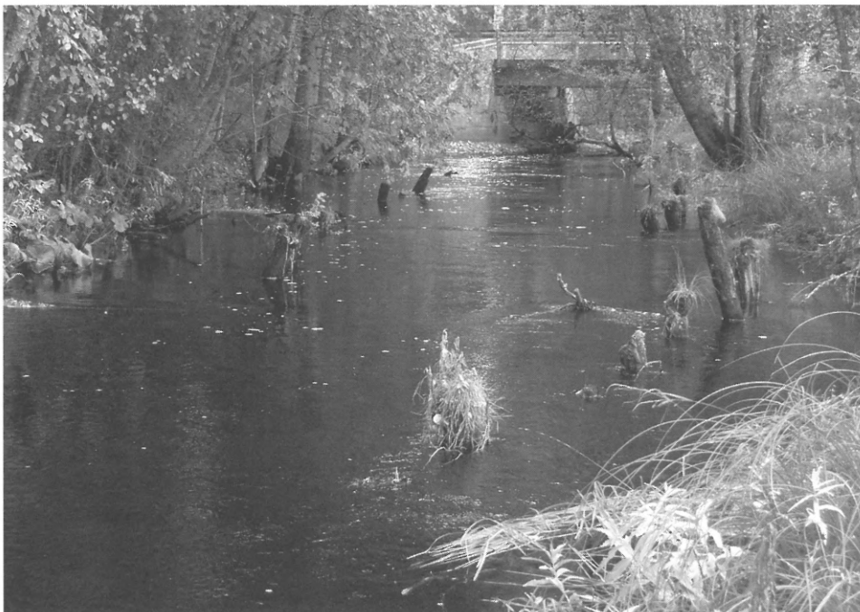
Perkuumiehet kaivoivat jokea ja rakensivat sinne tolpat pitämään joen reunoja vuosisadan taitteen 1800-1900 vaiheilla. Jotkut tolpat ovat yhä näkyvissä. (Kuva Vilho Perälä)
