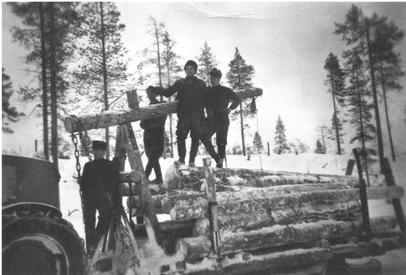
Savotalla oli käytössä niin sanottu puupuntari, jossa oli metallinen kela ja vaijeripyörät. Puupuntarin saattoi tehdä työmaalla.
