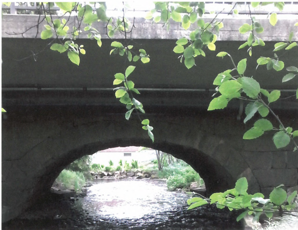
Pappilankosken sillan eli Kanan sillan kansi on nykyisin betonista, mutta vanhan kivisillan rakenteet on säilytetty.
