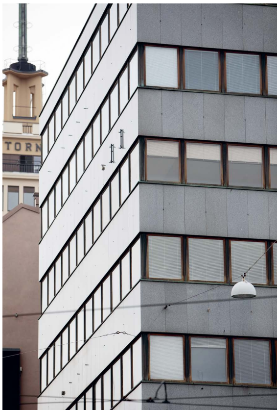
Aktian talossa on käytetty laadukkaita materiaaleja. Julkisivun pinta on kiillotettua graniittia ja ikkunanpuiteet tammea, listat pronssia. Myös jalankulkutason sisäänvedon jalopuinen alakatto on säilynyt alkuperäisenä.
