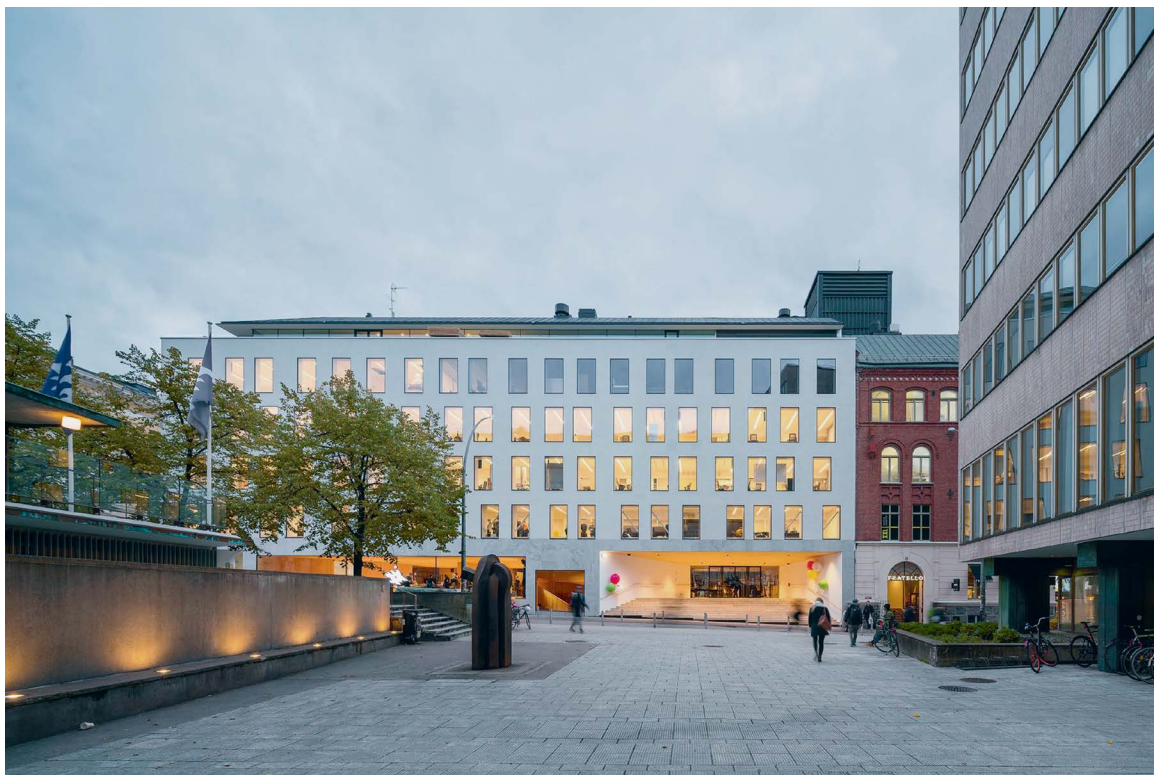
Arkkitehtitoimisto JKMM muokkasi vuonna 1971 valmistuneen hallintorakennuksen uuteen käyttöön Helsingin yliopiston Tiedekulmaksi. Haasteena olivat muun muassa matalat kerroskorkeudet, mutta huolellisella suunnittelulla korjaus onnistui. Uusittu rakennus avautui 2017.
