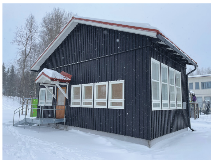
Yllä ja vas. Vanhan puukoulun pääty saatiin säilymään sellaisenaan samalla tontilla. Kooltaan paviljonki vastaa noin puolikasta alkuperäistä luokkahuonetta sivukäytävineen.
