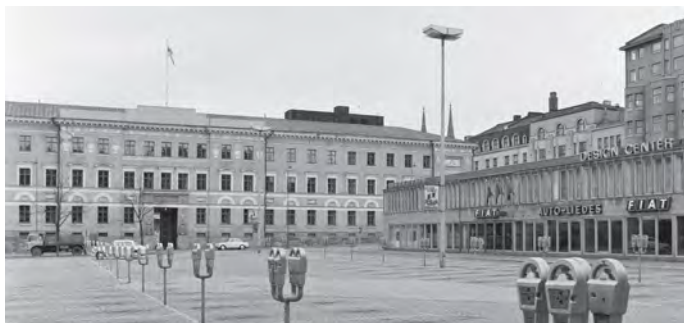
Ylh. Engelin suunnittelema Kaartin lasaretti korttelista on jäljellä kaksikerroksinen päärakennus ja läntinen siipirakennus.
