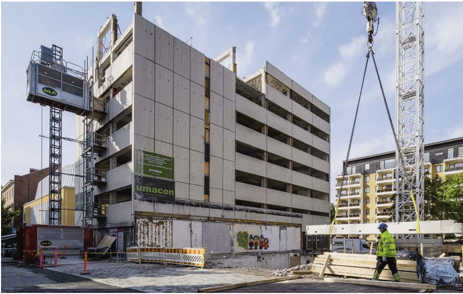
Tampereen keskustassa sijainneesta 1980-luvun toimistotalosta irrotettiin syksyllä 2023 purkamisen yhteydessä lähes kolmesataa betonielementtiä uudelleenkäyttöä varten.
