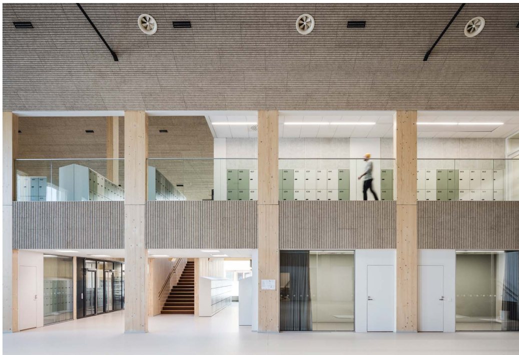
Halkosuontien koulun laajennus toteutettiin puurunkoisena.
