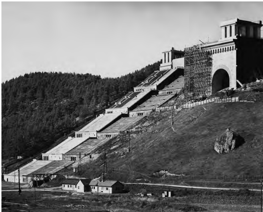
Albert Speerin Nürnbergin puoluepääväyläalueelle suunnitteleman jättiläisstadionin katsomon kaltevuus testattiin Hirschbachiin vuonna 1937 rakennetun täysikokoisen mallin avulla.
