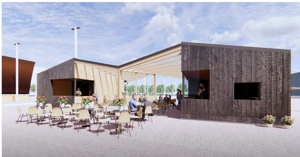
Vaalea CLT-elementtien pinta ja hiilletystä puusta tehty julkisivulaudoitus luovat kahvion ilmeeseen kontrastia.
