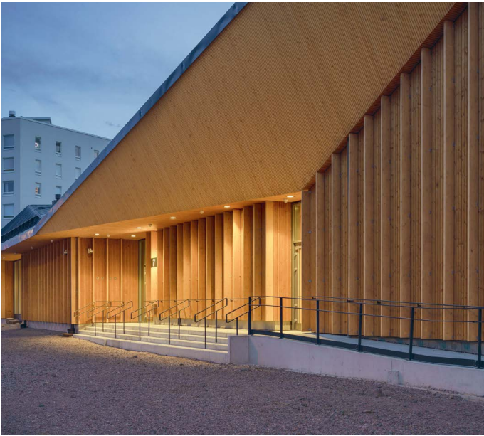
Postivarikon puinen alakatto liittää yhteen rakennuksen sisä- ja ulkopuolen. Seinien puusuurelementit tulivat valmiina tehtaalta, jossa niihin oli kiinnitetty ikkunat aulan lasipintoja lukuun ottamatta.
