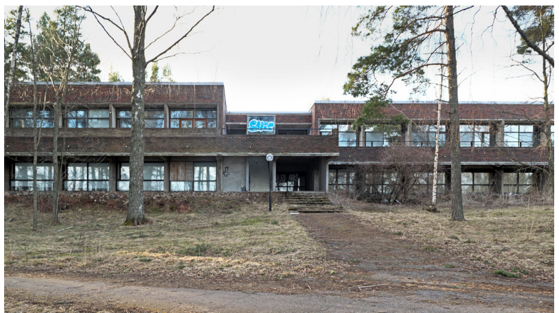
Pitkään tyhjiillään ollut Vuoranta ehti päästä huonoon kuntoon. Hienolla paikalla meren rannalla sijaitsevan, vuonna 1971 valmistuneen rakennuksen on suunnitellut Helmer Stenros.
