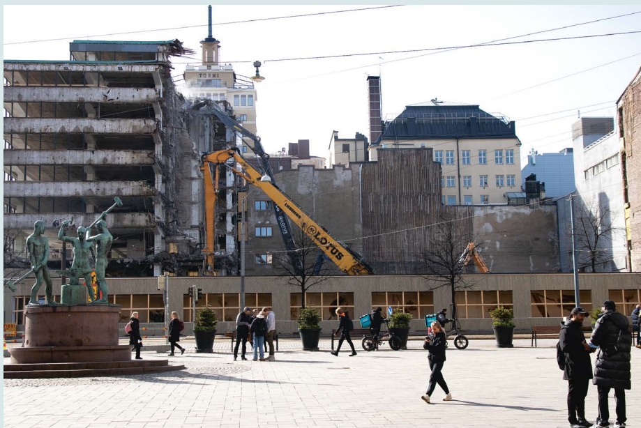
Purkamisen aiheuttamat päästöt lasketaan mukaan rakennuksen hiilijalanjälkeen. Kuvassa Mannerheimintie 14:ssä sijainneen toimistorakennuksen purkua keväällä 2023.
