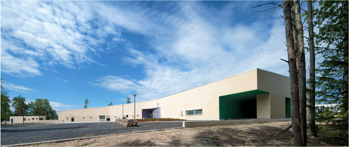
Mårtensbron koulu Espoossa syntyi arkkitehtuurikilpailun seurauksena. Vuonna 2012 valmistuneen koulun suunnittelusta vastasi Playa Arkkitehdit.
