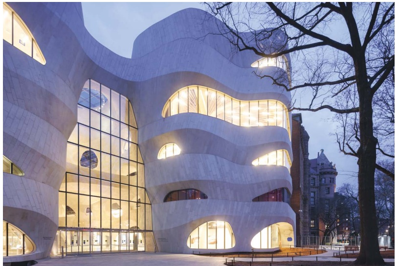
Studio Gang suunnitteli laajennuksen New Yorkin luonnonhistorialliseen museoon. Kanjonin muodoista inspiroituneen pääsisäänkäyntialuan toteutustavaksi valittiin kokeilujen jälkeen ruiskubetoni.
