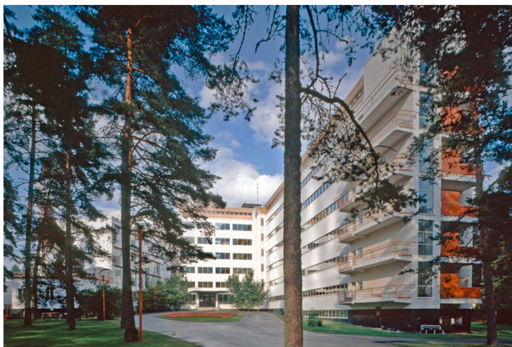
Alvar Aallon suunnittelema Paimion parantola. Rakennukselle etsitään uutta käyttöä.
