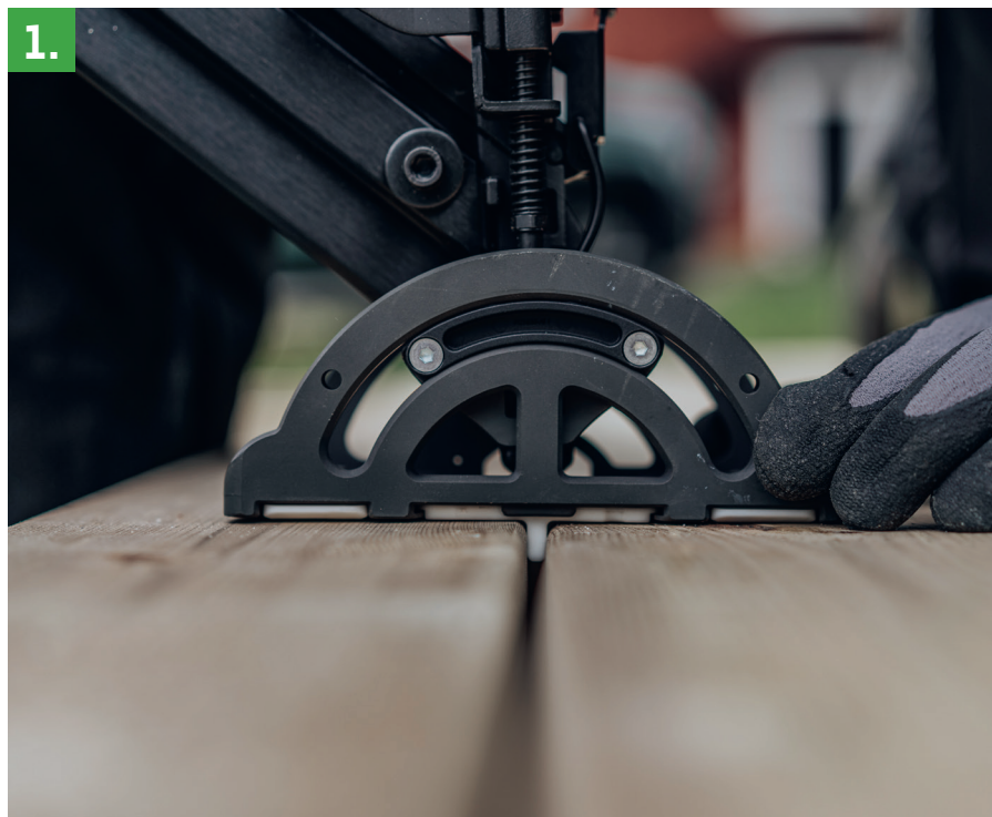
1. Välikkapaleet varmistavat että etäisyys pysyy tasaisena
