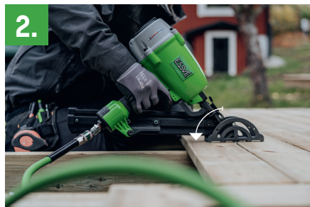
2. Naulat asennetaan laudan sivuilta
