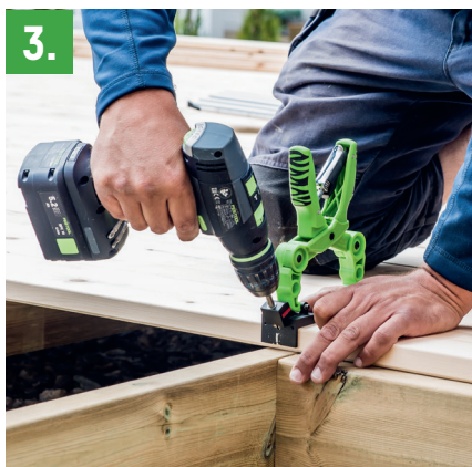
3. Käännä ruuvinväännin sellaiseen asentoon, että akku ei osu terassilautaan. Tämä pienentää asennusvirheiden ja asennustyökalun ja kärjen vaurioitumisen riskiä.
