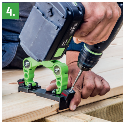
4. Käytä asennukseen HDS-kärkeä. Aloita aina ulommasta ruuvista.
