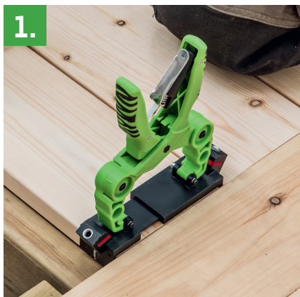
1. Kiinnitä asennustyökalu.
