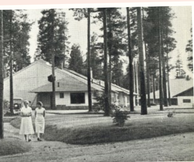
in ammattioppilaitos on arkkitehti Viljo lin suunnittelema. Rakennukset ovat ma- pääosaltaan vain yksikerroksisia, mutta loistavat tyyllisen kokonaisuuden.
