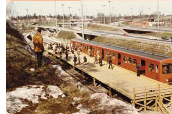
Metroa rakennetaan Siilitien metroaseman kohdalla.
