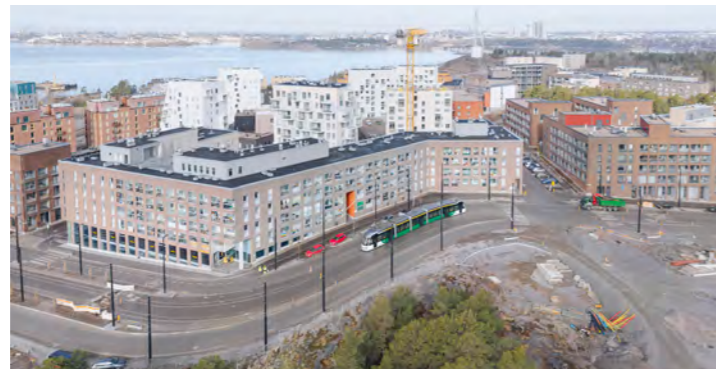
Linjojen 11 ja 12 yhteinen reittiosuus kulkee Kruunuvuorensiltaa pitkin. Sillalla ajetaan 70 km/h.
