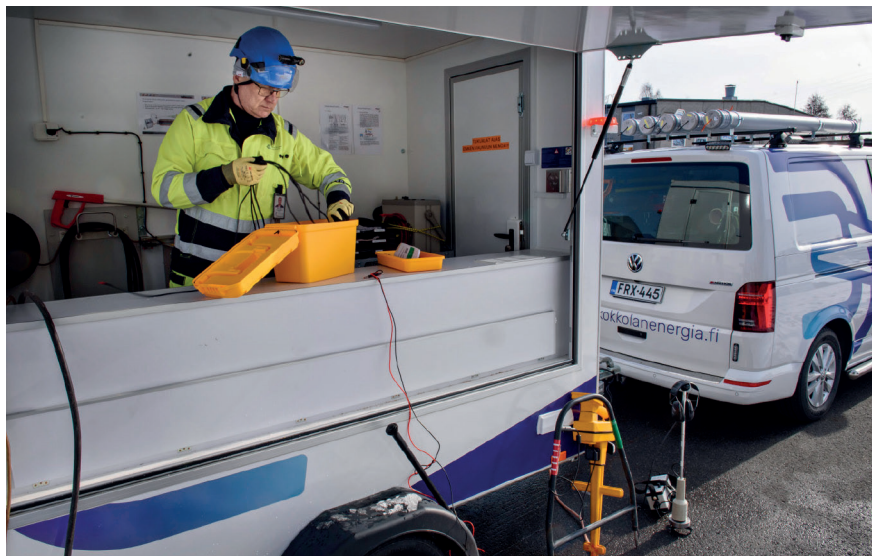
Sähköasema-asentaja Risto Ekdahl varustelee laitteistovaunua valmiiksi seuraavaa lähtöä varten.
