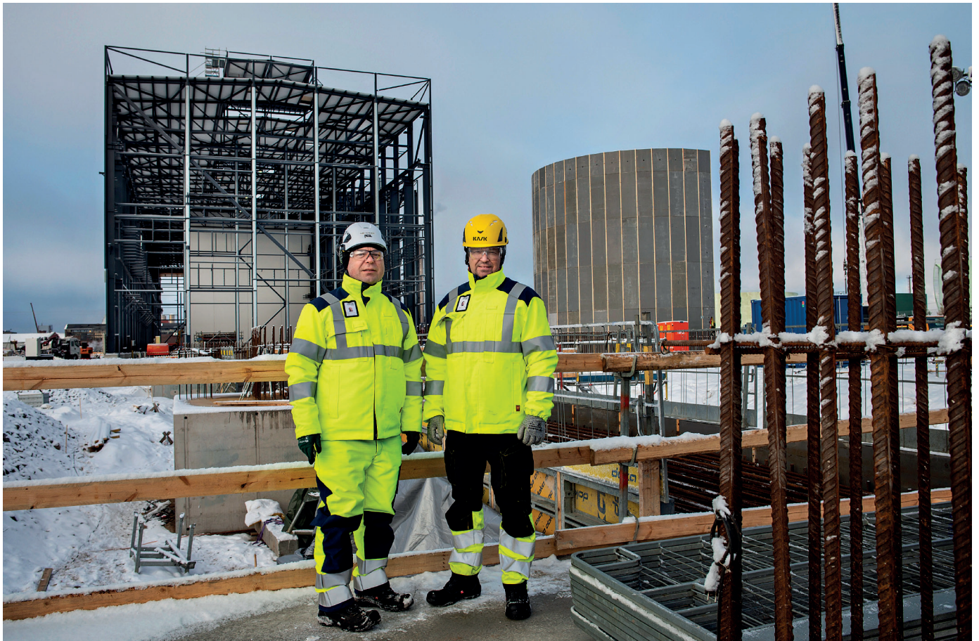
Sibanye-Stillwaterin Keliber-litiumhankkeessa nesteytettyä maakaasua käytetään rumpu-uunissa tapahtuvaan rikasteen lämpökäsittelyyn. Rakenteilla olevan rumpu-uunin perustuksilla litiumjalostamon päälikkö Sami Heikkinen (vas.) ja tehdaspalvelujohtaja Manu Myllymäki.
