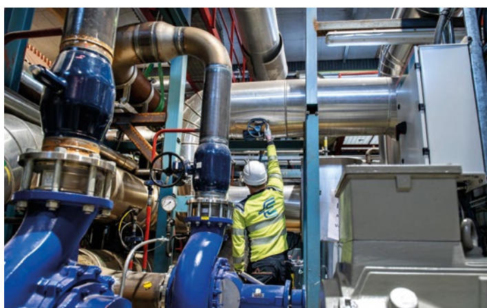
Vid saneringen av elcentralen i Kosil förnyades bland annat el- och automationssystem och oljebrännare.
