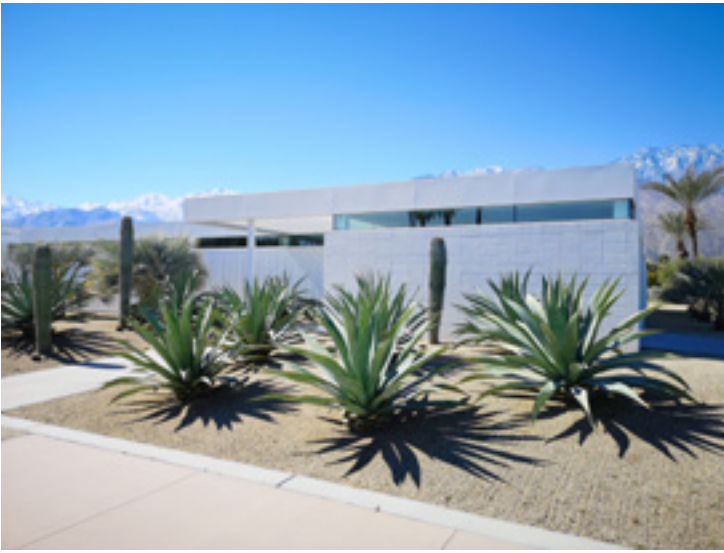
Kadun puoleinen julkisivu on suojaista ja pelkistetty. Katon rajassa olevista ikkunoista tulee sisälle valoa.
