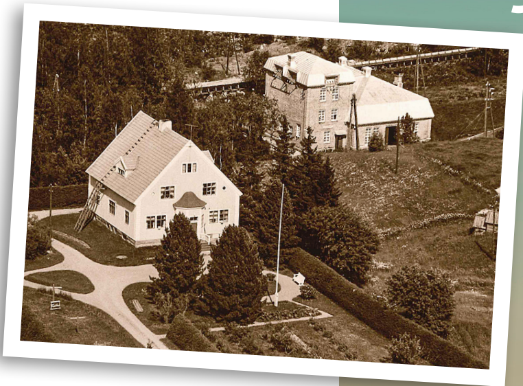
Korpelan Voiman konttori ja voimalaitos Yli-Kannuksessa 1950-luvun lopulla.
