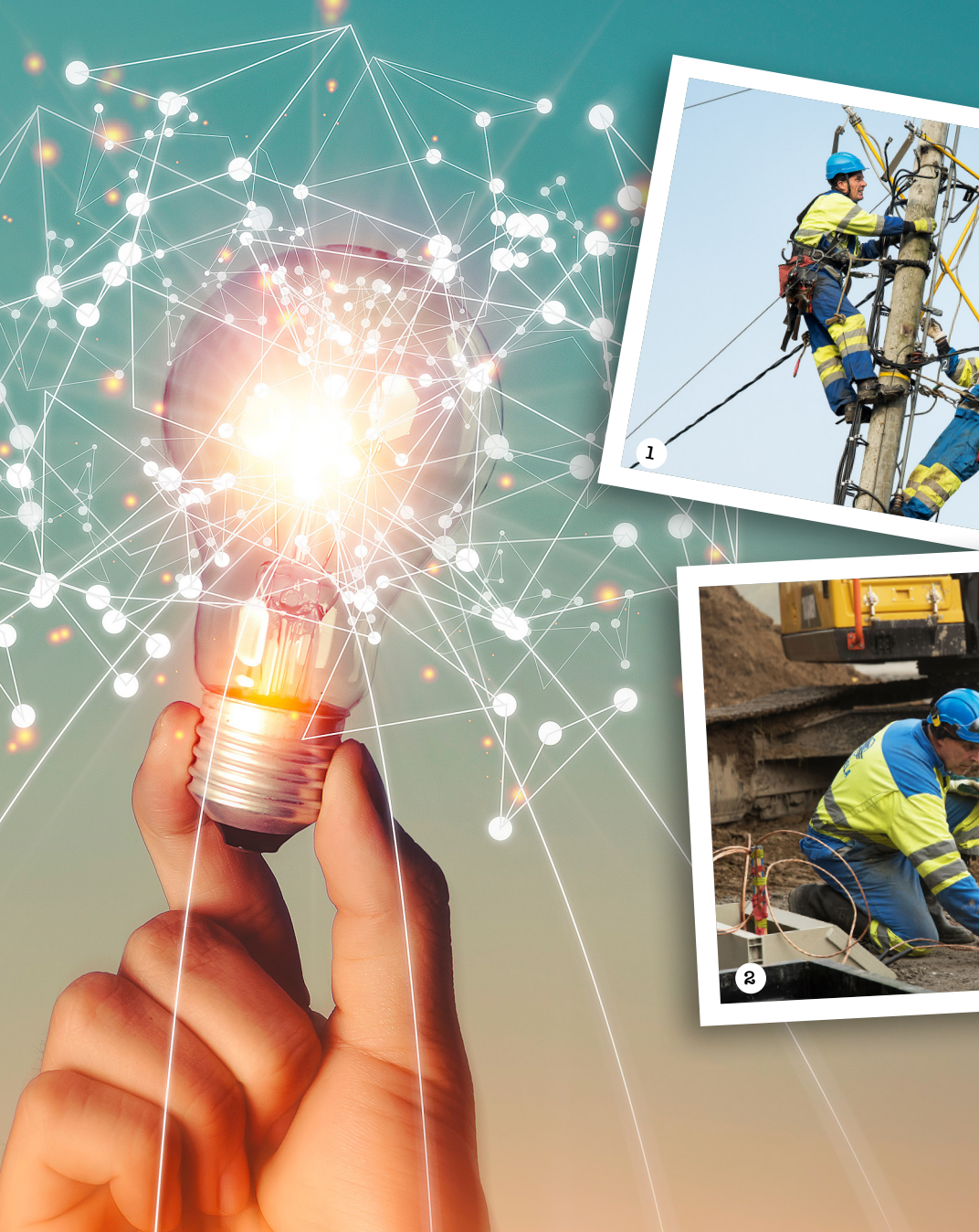
1. Verkko Korpelan asentajia pylväsmuuntajaa vaihtamassa. 2. Maakaapelointityömaalla. Kuvat: Korpelan Voiman arkisto.
