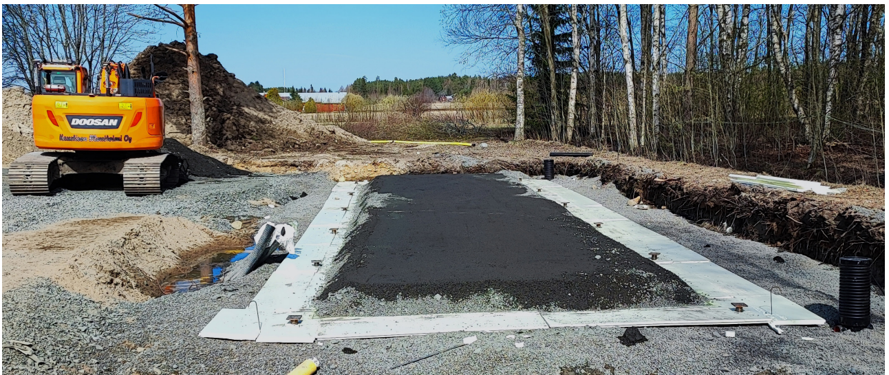
Kaustisen sähköaseman rakennustyömaa.
