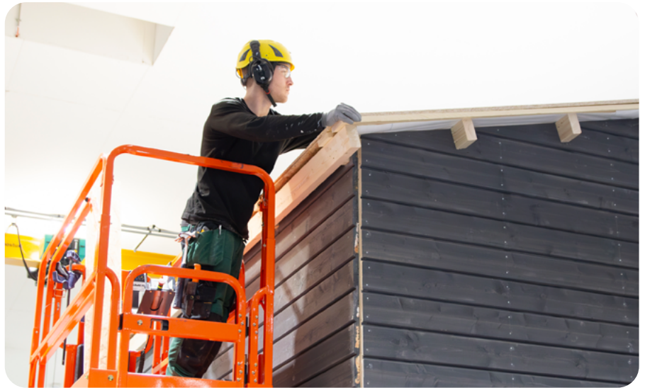
Laitetilat valmistetaan ja tarvittaessa myös varustellaan kuivissa sisätiloissa tehtaalla.
