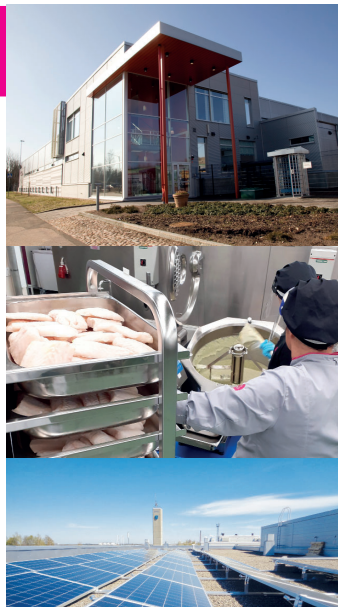
Keskuskeittiö Kapyysin katolle on asennettu 220 aurinkopaneelia. Aurinkopaneelien käyttö vähentää toimipisteen sähkönkäytön aiheuttamia hiilidioksidipäästöjä n. 8 700 kg vuodessa.
