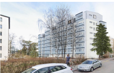
Melkonkatu 4:n korotuksesta ei tule helposti huomaamaan, että itse asiassa keskellä taloa on muutoksen jälkeen yhdeksän kerrosta. Kuva kaavaselostuksen viitekuvista.
