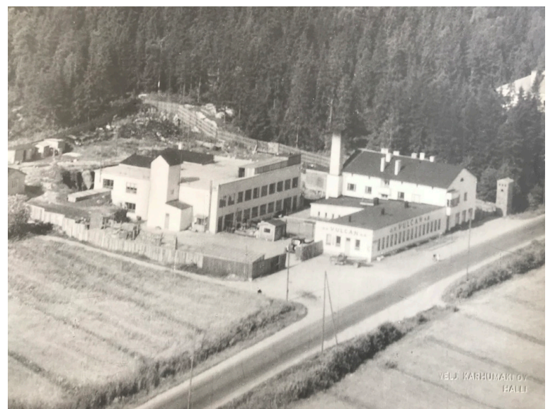
Ilmakuva tehdaskiinteistöstä 1940-luvun lopulta.
