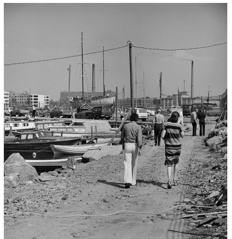
Aluehallintovirasto on antanut vuonna 2023 Helsingin kaupungille vesiluvan Lohiapajanlahden ruoppauksille ja täytöille. Vesialuetta muutetaan maa-alueeksi kaikkiaan noin hehtaari. Täyttöön tarvittavan massamäärän arvioidaan olevan noin 52 000 kuutiota. Alueen merellinen ilmapiiri muuttuu pysyvästi.
