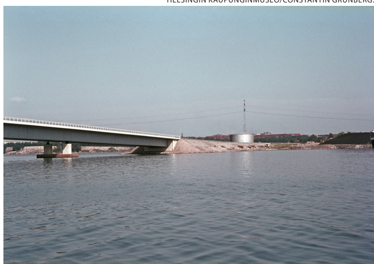
Lapinlahden sillan itäpää vuonna 1967.
