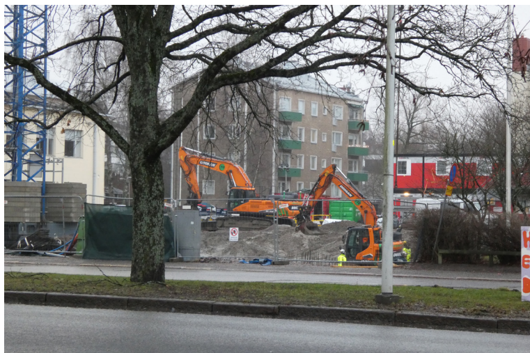
Skolbyggnadens A-del, som byggdes på 1930-talet, och B-del, som utvidgades 1949, skall renoveras. C-delen, som färdigställdes 1987, har rivits ner.
