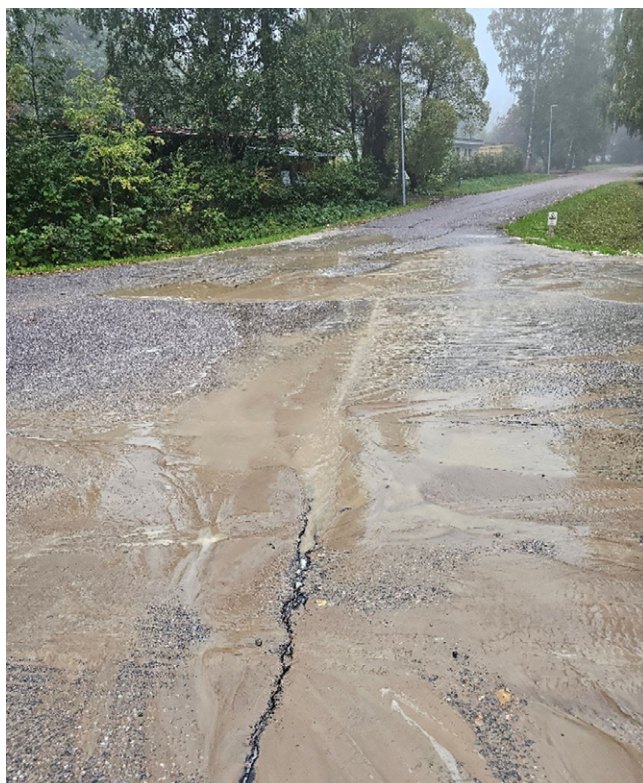
Maan pinnalle tullut vesijohtovuoto.
