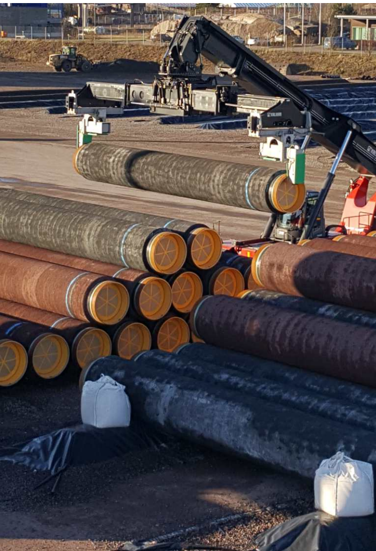
Kotkassa pinnoitettujen kaasuputkien laivaukset Koverharin välivarastoon alkoivat 17.9.
